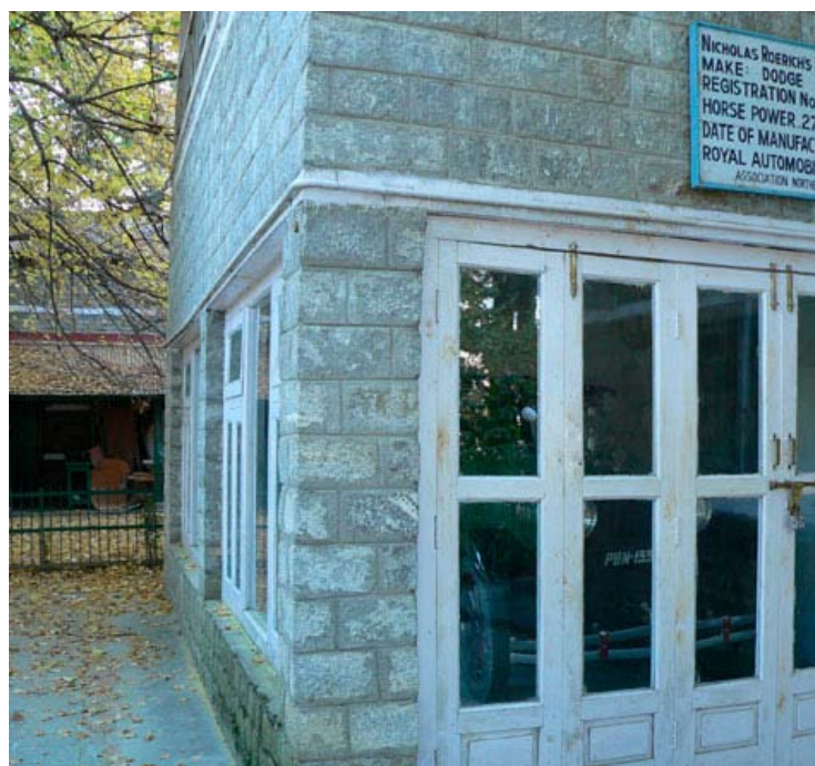
Современный вид гаража, пристроенного к северному фасаду. 2010г.
