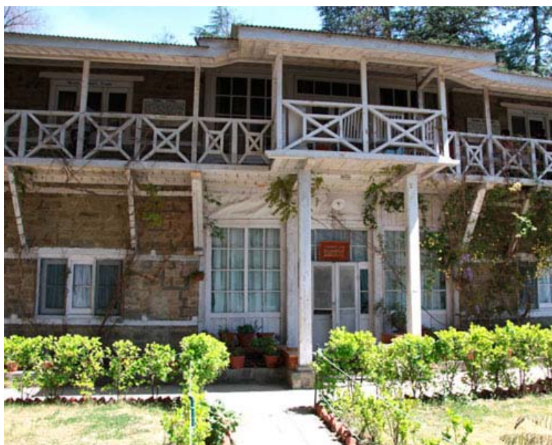
Дом Рерихов. Современный вид западного фасада.
