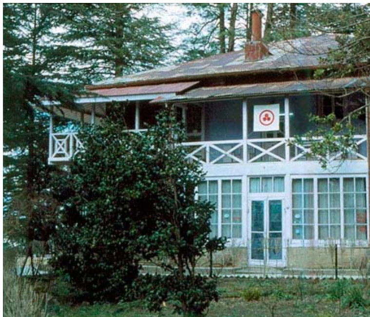
Дом Рерихов. Современный вид южного фасада.
